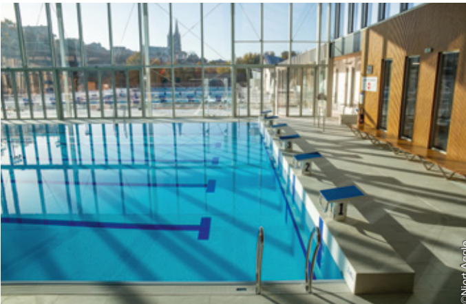
Le bassin sportif couvert de 25 x 15 m (six couloirs, profondeur de 2 à 2,40 m) est équipé d'un demi-fond mobile permettant de faire varier la profondeur de 2 m à quelques centimètres, pour l'apprentissage de la natation ou pour d'autres activités. Il est homologué pour les compétitions régionales et départementales en natation course et water-polo.
