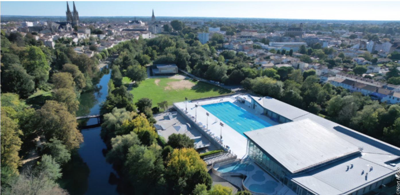
En transformant les contraintes en moteur pour réinventer la piscine du Pré Leroy, la Collectivité prouve qu'il est possible de tendre vers un modèle de gestion durable. Le projet a notamment permis la transformation du bassin extérieur de 50 m en bassin nordique.
